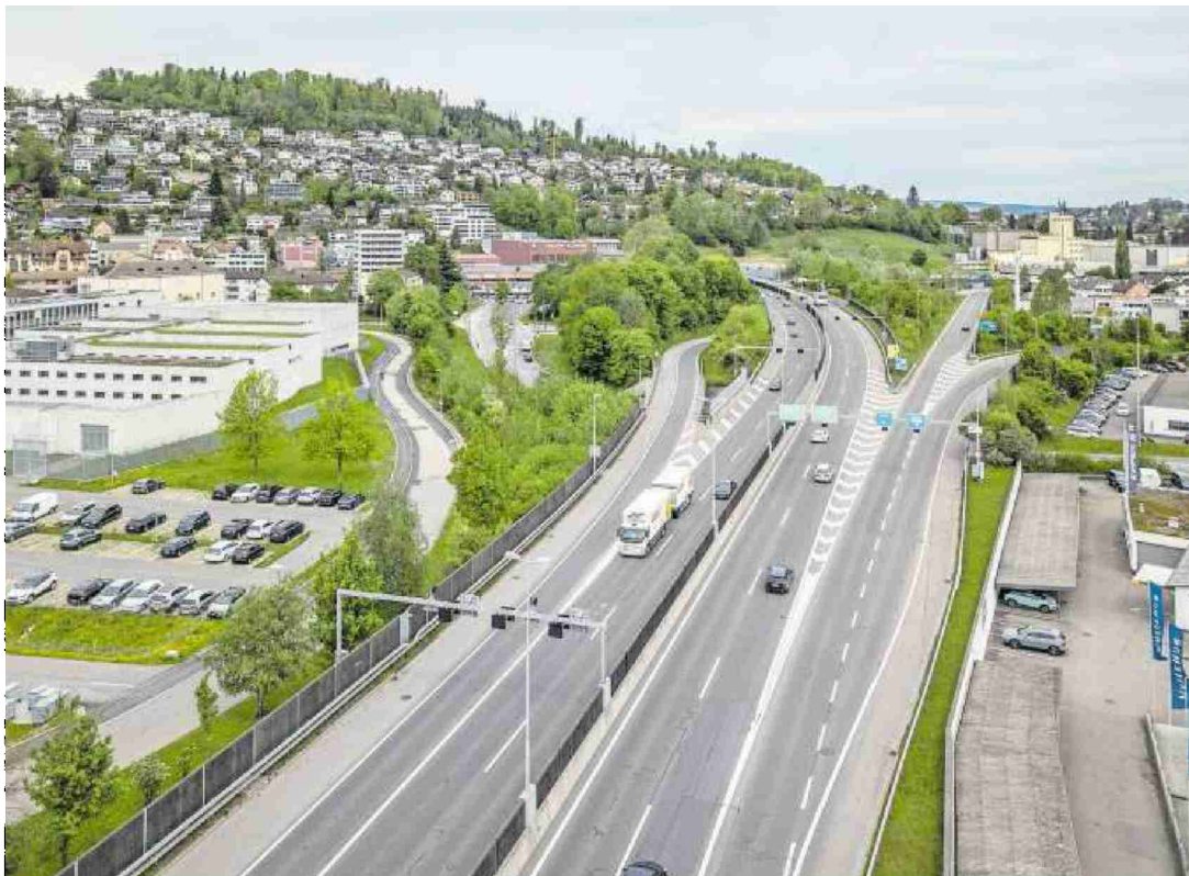
Die A2 zwischen Sonnenberg- und Schlundtunnel.
